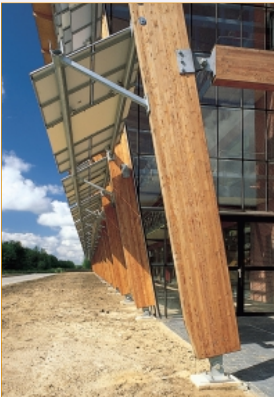
△ Hellende kolommen van gelamineerd lariks in de voorgevel van het Adverium te Drachten. Ontwerp: Van der Breggen Architect BV Alphen a/d Rijn/Drachten.
