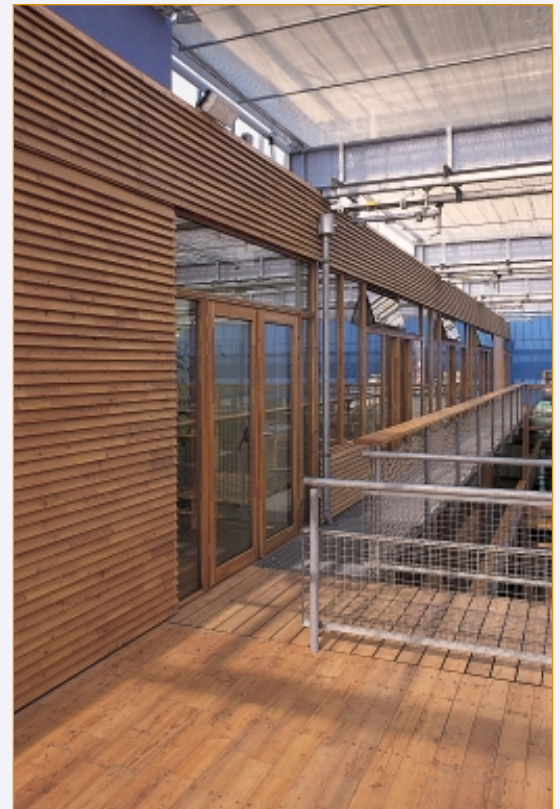
▷ Strak lariks op de vloer en gepotsekseld in de wand. IBN-DLO (thans onderdeel van Alterra) Wageningen. Ontwerp: Behnisch, Behnisch & Partner Stuttgart.
