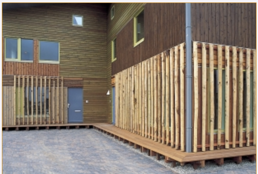
△ Privacyschermen van lariks rondhoutstammetjes, in de hoek lariks gevelbekleding. Houtskeletbouwproject Zenderpark IJsselstein; ontwerp: Jean Désert rem. Den Haag.
