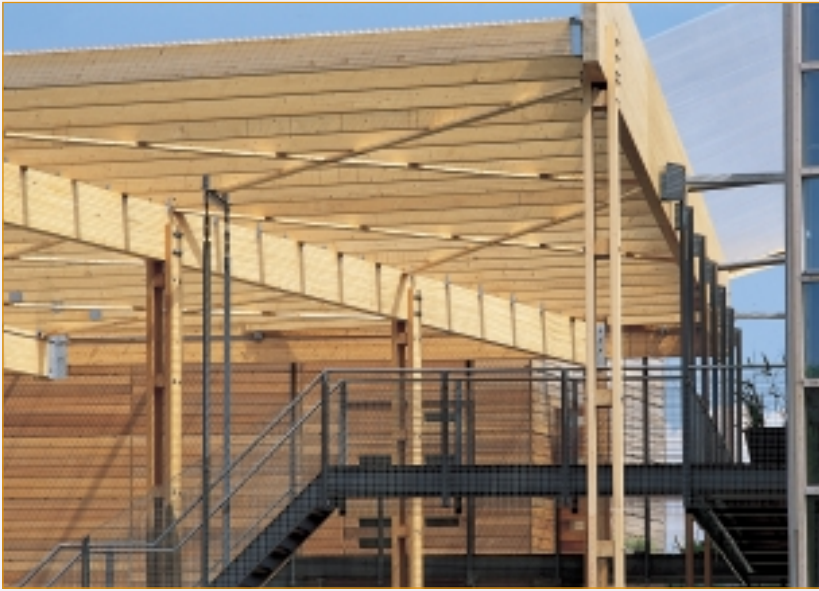
◁ Stadslandgoed De Kemphaan in Almere; ontwerp: Paul Santman Architecten Almere. Constructie van lariks kolommen en liggers en vuren gordingen.
