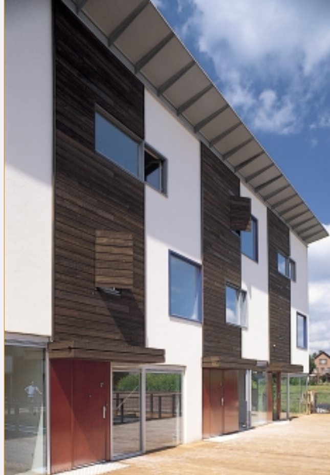
△ Project De Landjes in Nieuw-Terbregge; ontwerp: Mecanoo architecten BV Delft. Gevelbekleding van Siberisch lariks, behandeld met een donkere olie.
