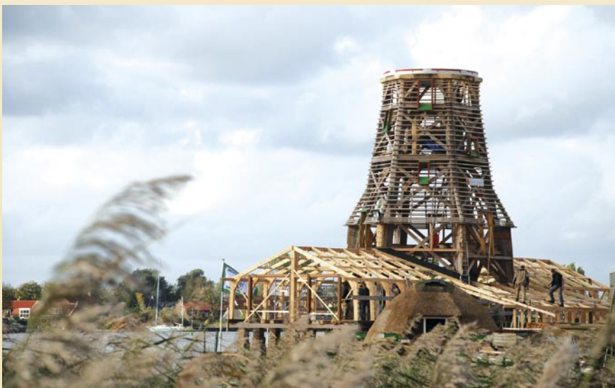
De bouw van de nieuwe houtzaagmolen 'Het Jonge Schaaap' op de Zaanse Schans vergde veel speciale maten in Grenen, Lariks en Douglas.
